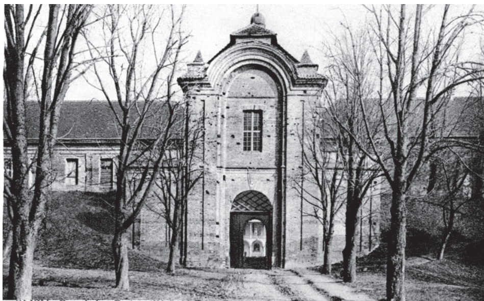
OŁYKA. Zamek ks. Radziwiłłów. — Brama wjazdowa.
