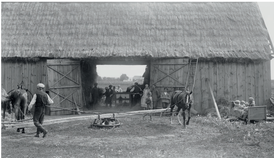
Narcyz Witczak-Witaczyński, Życie codzienne w Osadzie Krechowieckiej na Wołyniu. Młocka w gospodarstwie starszego wachmistrza Józefa Stobniaka. Na pierwszym planie konny kierat napędzający młockarnie. W stodole ludzie pracujący przy młockarni.
