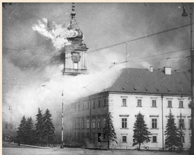
Płonąca wieża zegarowa Zamku Królewskiego, 17 września 1939 r.
