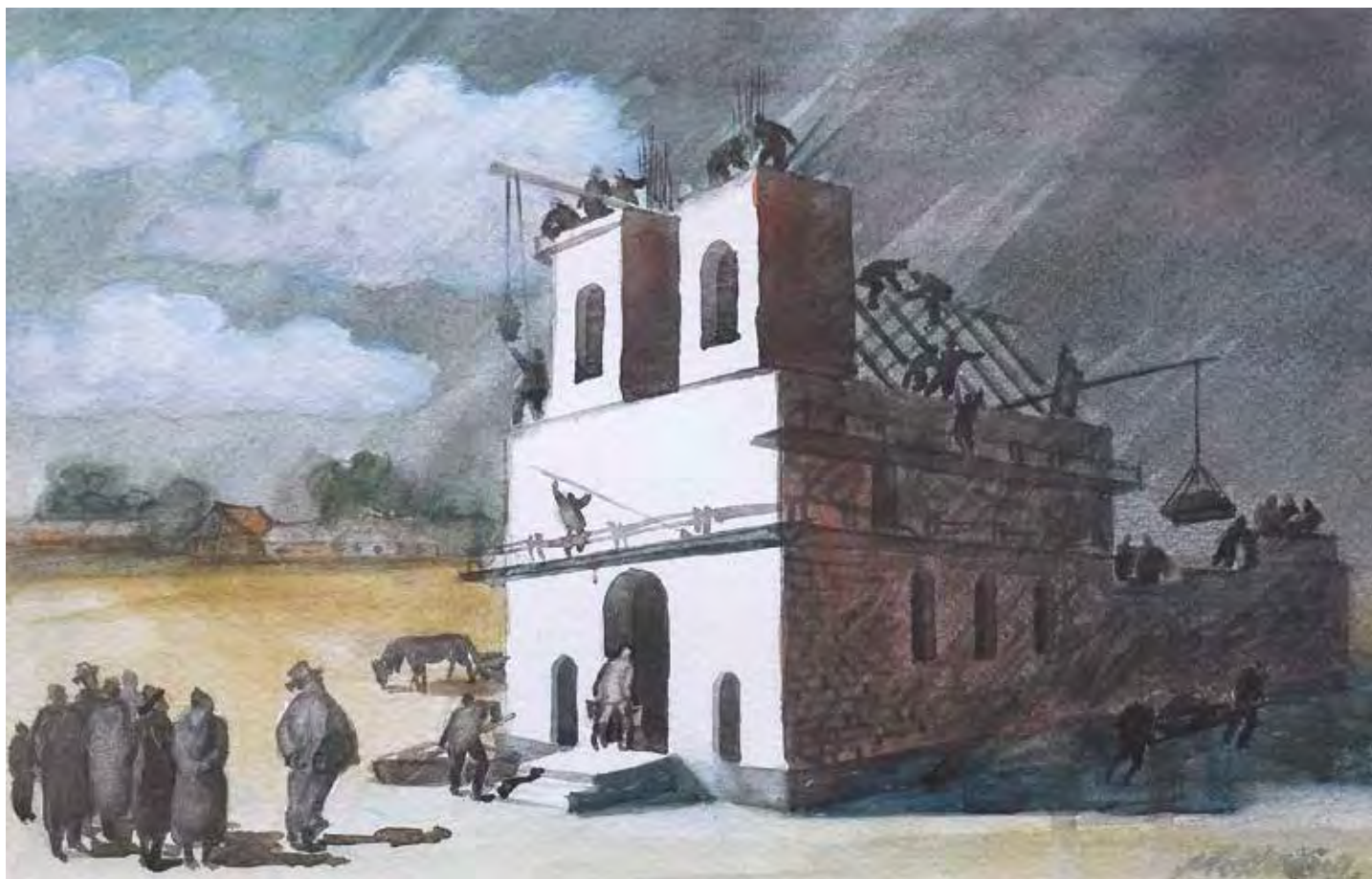
71. Feliks Mostowicz (1947–2020); Budowa kościoła w Oziernoje (obwód kokczetawski) ; Nr Inw. Gr.3327
