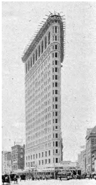
1. Budynek Flatrion, widok z początku XX wieku. Źródło: domena publiczna
