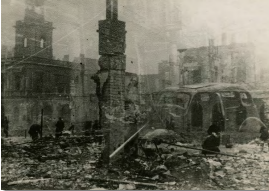
89. Warszawa zburzona w czasie II wojny światowej. Zniszczony działaniami wojennymi budynek Dworca Kolei Warszawsko-Wiedeńskiej przy ulicy Marszałkowskiej (MN F-14726)
