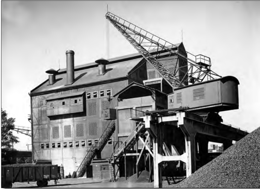
40. Gazownia Miejska w Warszawie. Piecownia systemu Glover – West (3/1/0/8/1787)
