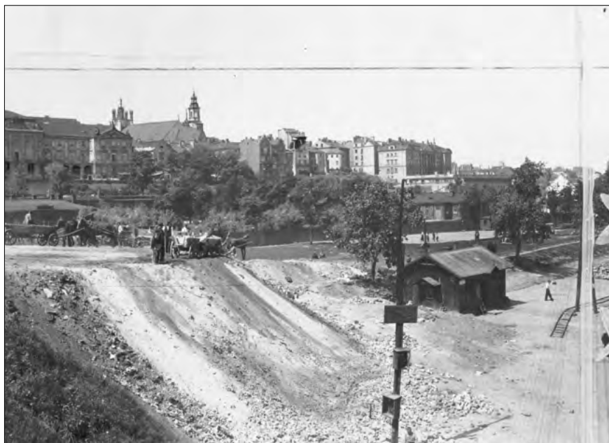
32. Warszawa. Wybrzeże Gdańskie. Budowa bulwaru (NAC 3/1/0/9/6916)
