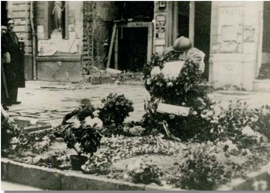
90. Grób na chodniku w Alejach Jerozolimskich w Warszawie (MN F-14730)
