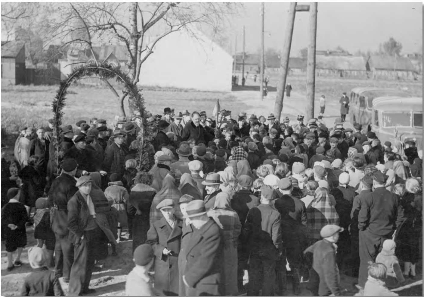
67. Uruchomienie wodociągów w Warszawie, 24.10.1936 (NAC 3/1/0/8/6629)
