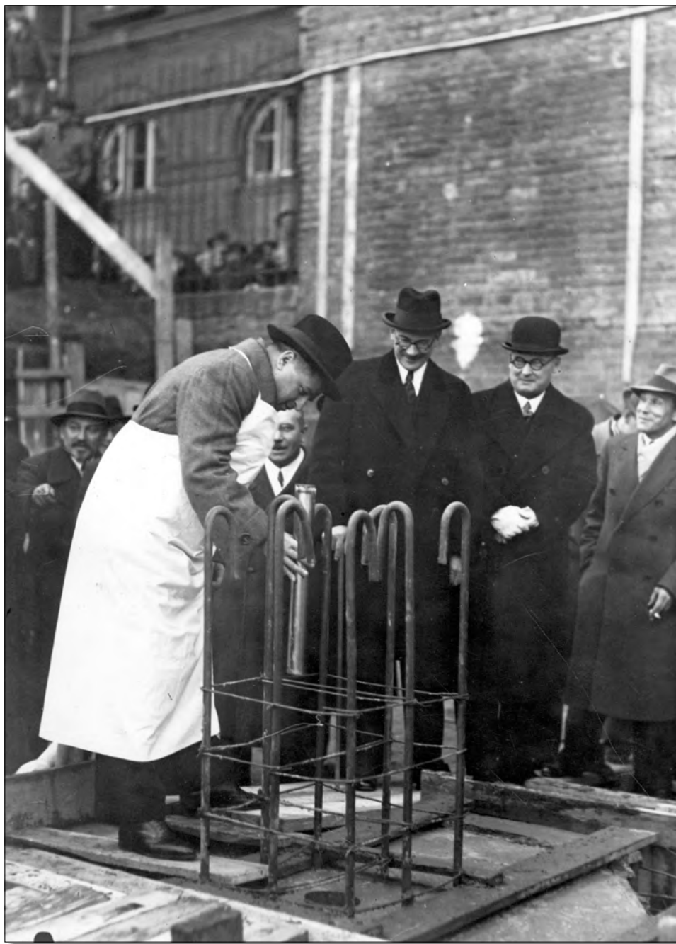
42. Poświęcenie kamienia węgielnego pod budowę budynku administracyjnego Elektrowni Miejskiej w Warszawie. Prezydent Stefan Starzyński dokonuje wmurowania aktu erekcyjnego, 10.1937 (NAC 3/1/0/8/1577)
