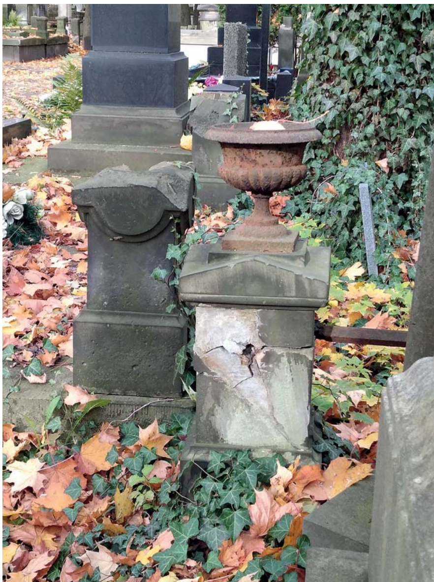
Fot. 3. Przykładowe uszkodzenia grobowca, autor: Jarosław Jaskólski
