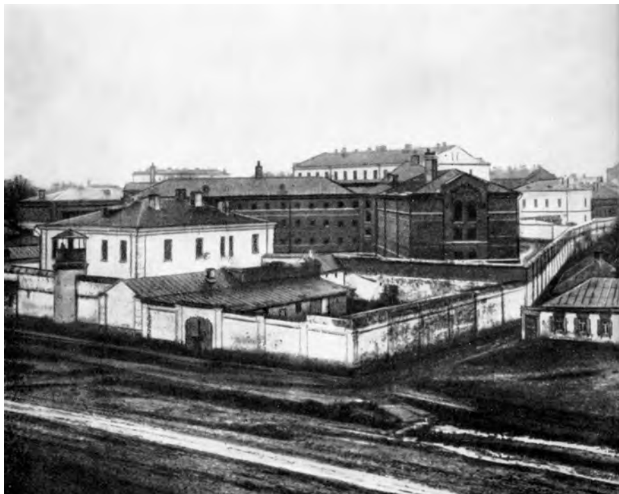
Centralne Więzienie Katorżnicze w Orle, widok ogólny
