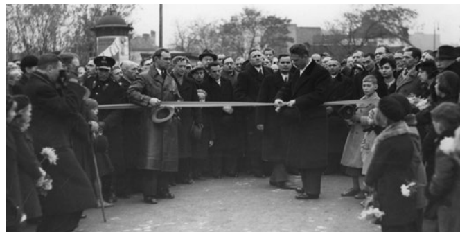
Uroczystość otwarcia nowo przebudowanej ulicy Puławskiej. Widoczny m.in. wiceprezydent Warszawy Jan Pohoski (przecina wstęgę)
