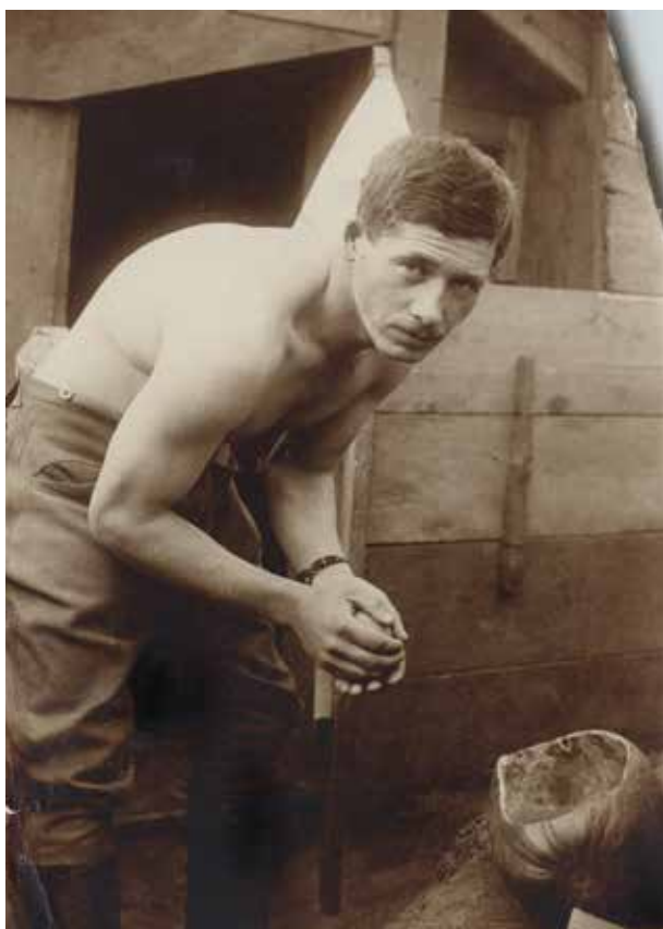
6. Poranna toaleta w arbuzie. Fot. nieznanym, Bukowina
