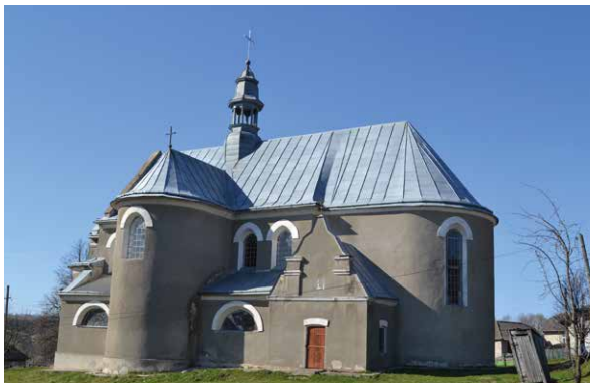
33, 34. Porchowa. Fasada i fragment elewacji bocznej kościoła pw. Matki Bożej Królowej
