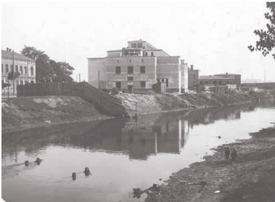
Więzienie karne w Częstochowie-Zawodziu, w którym przetrzymywano Stanisława Nowaka. Na fotografii podczas ostatniego etapu budowy (1931). Źródło: Narodowe Archiwum Cyfrowe, sygn. 662a.
