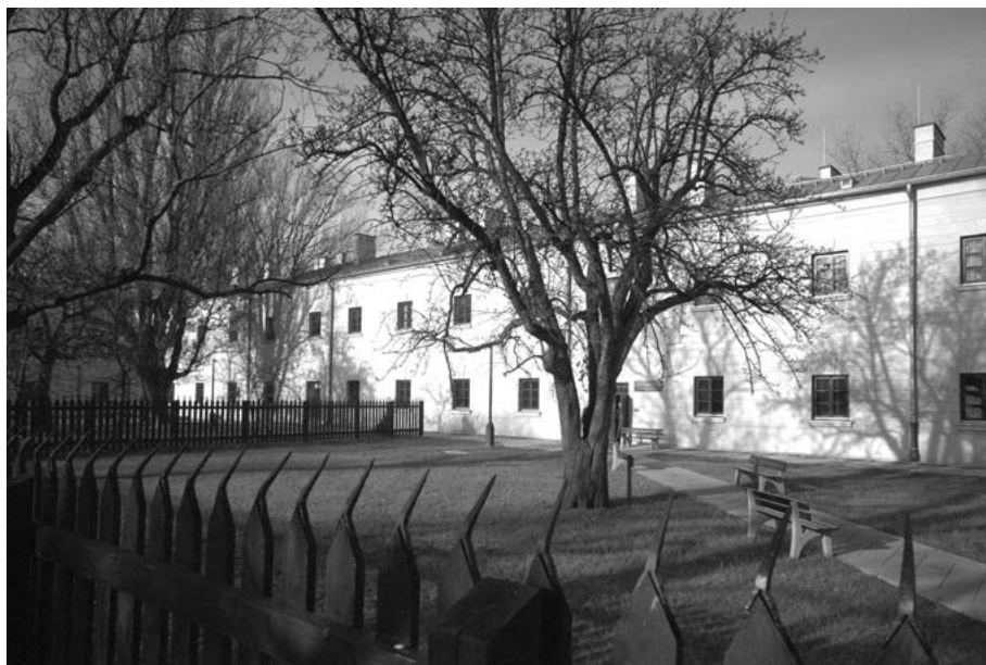
Fot 7. Budynek X Pawilonu po renowacji i zagospodarowaniu dziedzińca.
