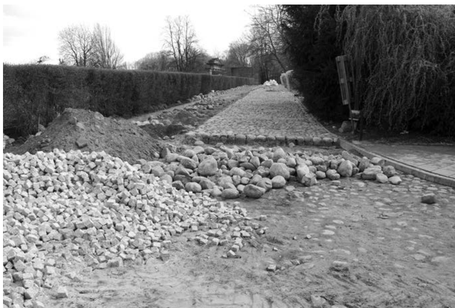
Fot. 4. Układanie bruku na Drodze Straceń.
