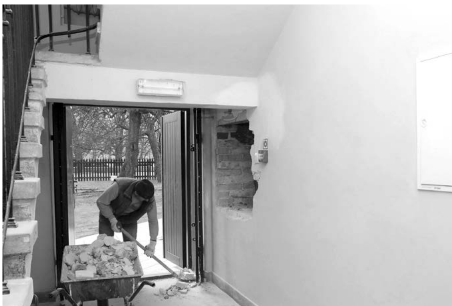
Fot 6. Prace remontowe przy głównym wejściu do budynku X Pawilonu.
