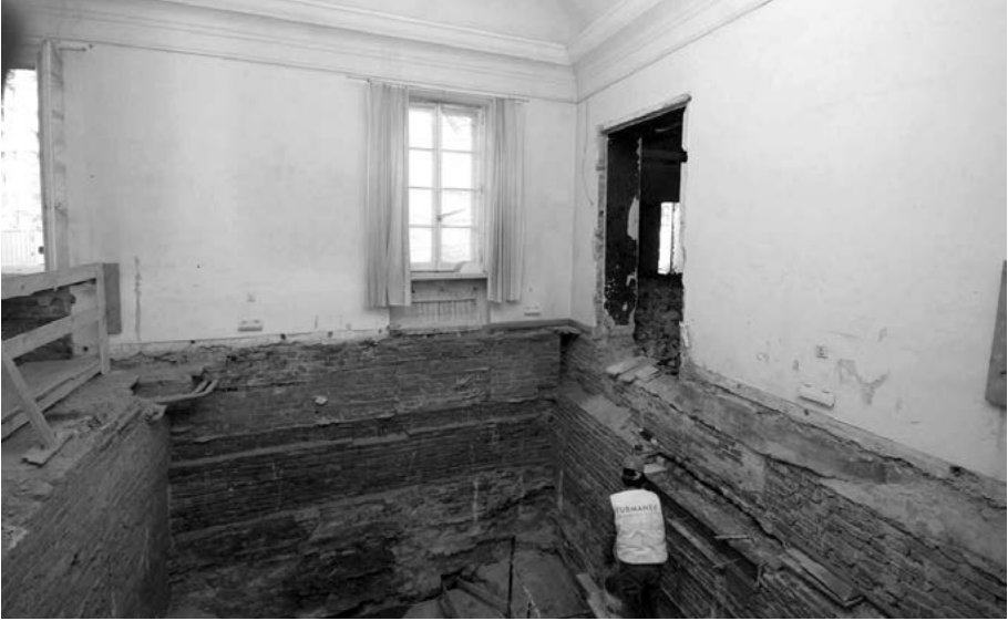
Fot. 3. Jeden z pracowników firmy „Furmanek” podczas prac odgruzowujących piwnice. Wbrew pozorom praca misterna i pełna obaw z uwagi na możliwość natknięcia się na różnego rodzaju „niespodzianki”.
