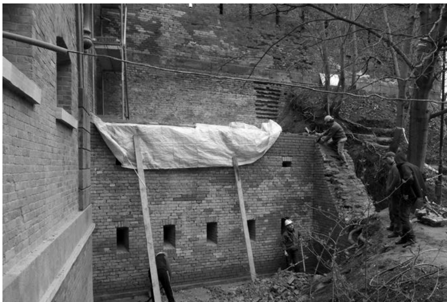
Fot. 2. Prace konserwacyjne przy murze zewnętrznym przed wjazdem do Bramy Bielańskiej.
