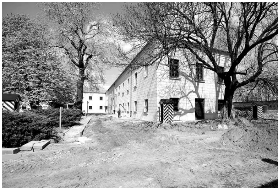
Fot. 3. Rekonstrukcja brukowanej ulicy Trojaka przy X Pawilonie.
