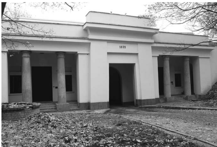
Fot. 8. Brama Bielańska po renowacji.
