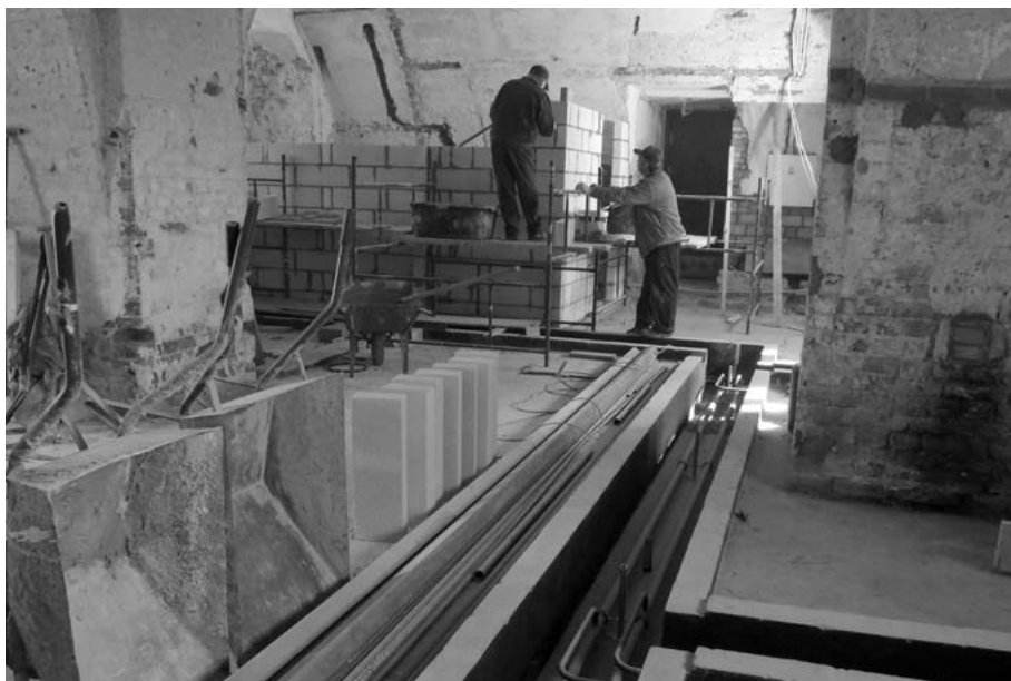
Fot. 1. Prace remontowe w budynku XI Pawilonu.
