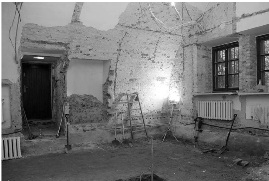
Fot. 5. Prace remontowe w budynku XI Pawilonu.
