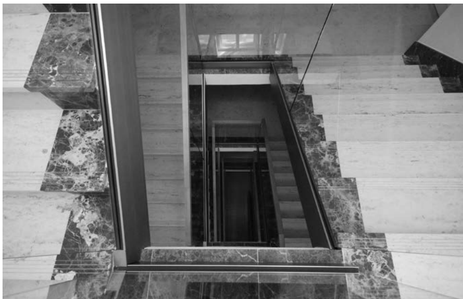
Fot. 11. Wybudowane zostały nowe, przestronniejsze i bezpieczniejsze klatki schodowe.
