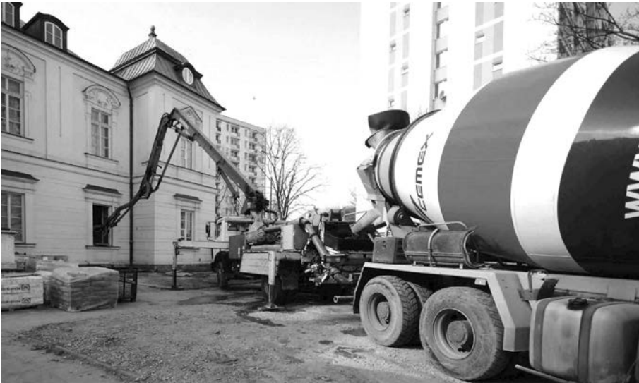
Fot. 2. Zdjęcie obrazujące prace przy wykonywaniu wylewki posadzek. Podjeżdżające betoniarki wylewają zaprawę do specjalistycznego podajnika, za pośrednictwem, którego materiał przekazywany jest do wnętrza budynku. Należy podkreślić, iż pomimo bardzo trudnej – przy tym ogromnym całościowym zakresie prac – lokalizacji obiektu, wszystkie prace przebiegały w niezwykle schludny i nie zakłócający dla otoczenia sposób.
