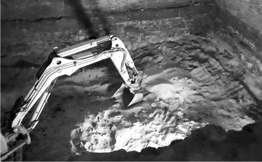
Fot. 1. Podczas prac rewitalizacyjnych wykorzystany został szeroki potencjał specjalistycznego sprzętu, niewidocznego dla przechodniów. Zdjęcie warto zapamiętania. Koparka użyta przy odgruzowaniu piwnic. Nadwyżki gruntu przetrucano na taśmociąg, pod którego drugi koniec, od strony parkingu, podjeżdżały wywrotki.
