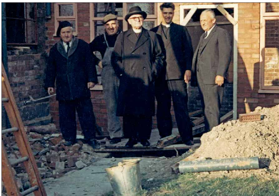
| Podczas inspekcji przy budowie nowego kościoła w Dunstable, 1968
