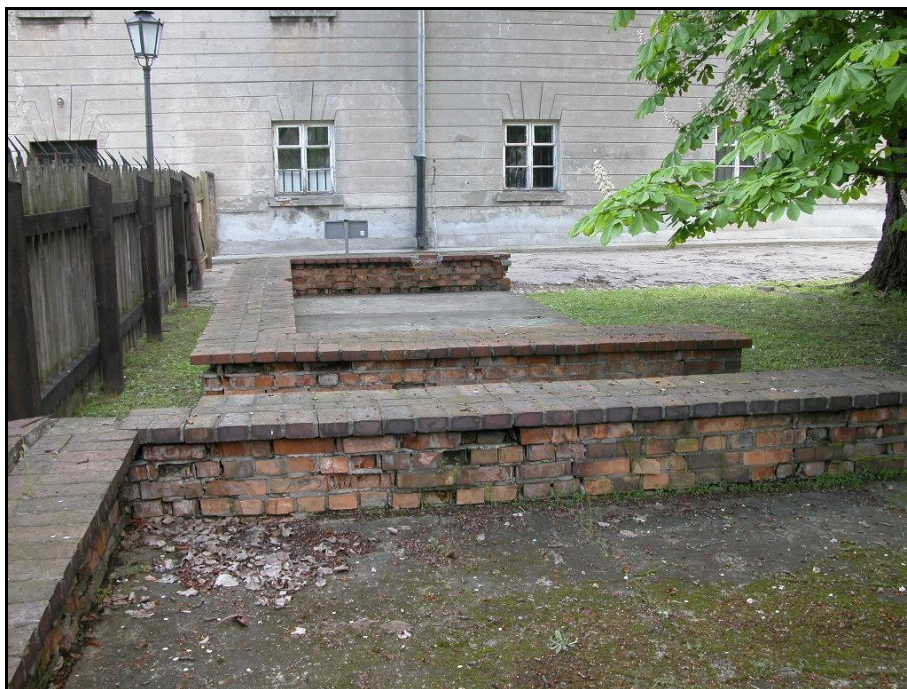
Fot. nr 35 Murek obrazujący przebieg starych fundamentów kuźni, murek oraz beton w złym stanie technicznym.
