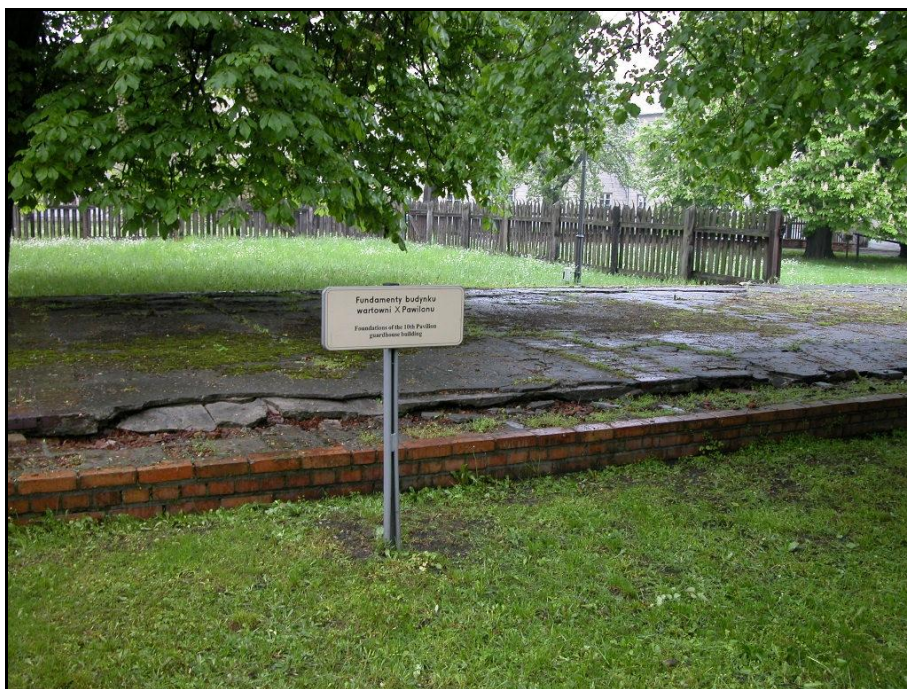
Fot. nr 28 Murek obrazujący przebieg starych fundamentów wartowni X Pawilonu, beton w złym stanie technicznym.
