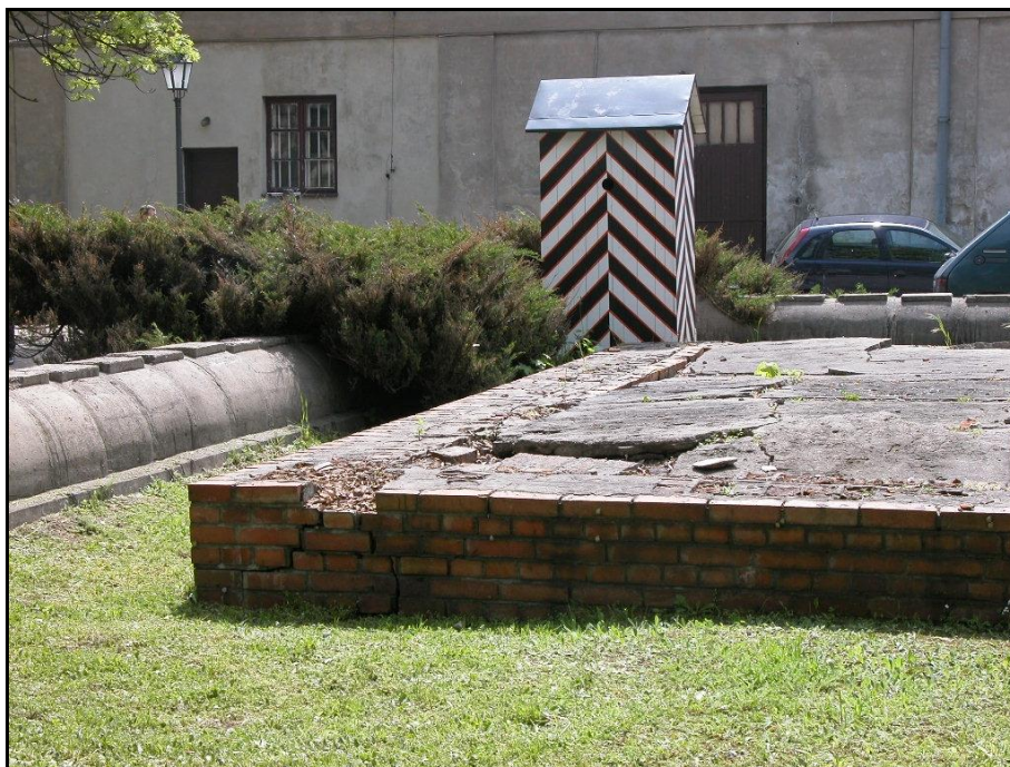
Fot. nr 31 Murek obrazujący przebieg starych fundamentów wartowni X Pawilonu, narożnik murku do przemurowania, beton w złym stanie technicznym.
