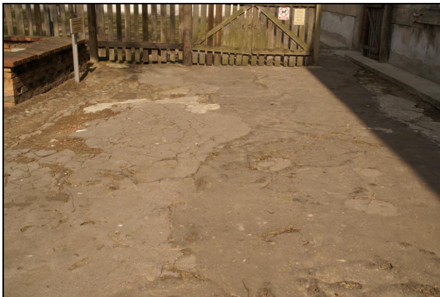
Fot. nr 16 Nawierzchnia asfaltowa, spękany asfalt.
