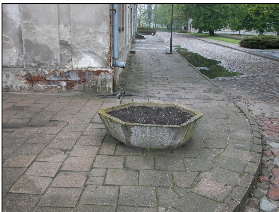
Fot. nr 4 Nawierzchnia z kamienia polnego, brak prawidłowych spadków, zapadliska tworzące zastoiska wody opadowej. Nawierzchnia chodnika z płyt betonowych o wym. 35 x 35 cm. Donica betonowa.
