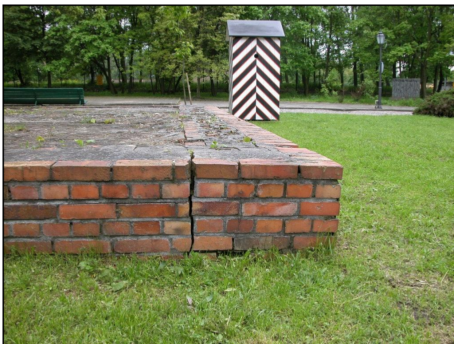
Fot. nr 32 Murek obrazujący przebieg starych fundamentów wartowni X Pawilonu, fragment murku do przemurowania.
