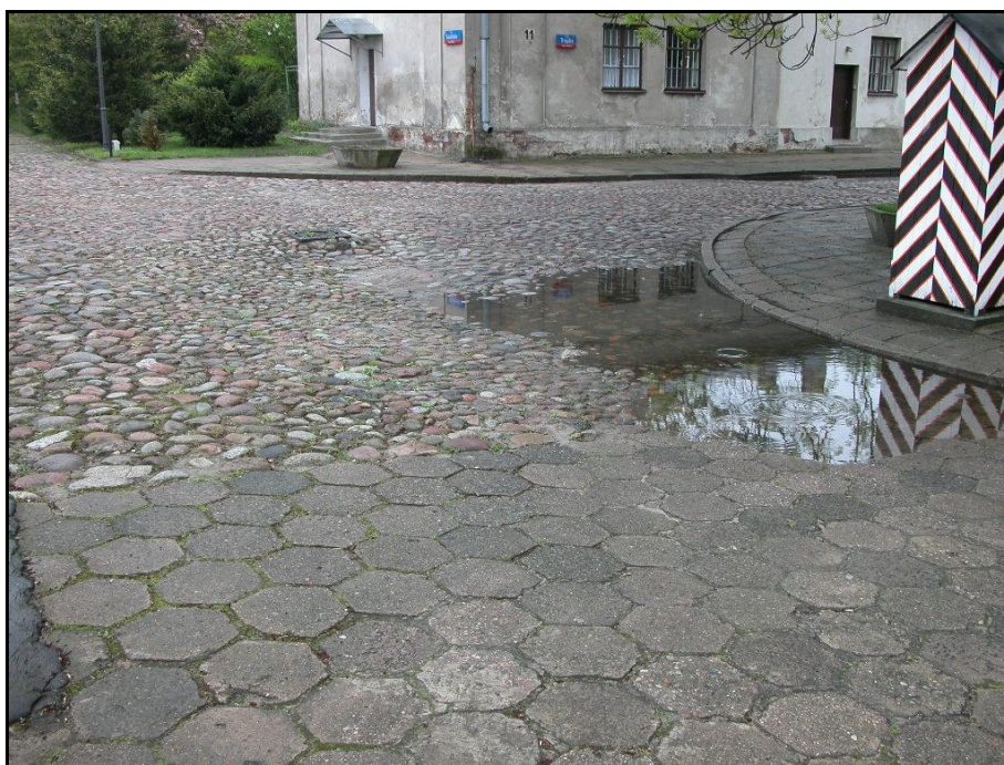
Fot. nr 3 Nawierzchnia z kamienia polnego, brak prawidłowych spadków, zapadliska tworzące zastoiska wody opadowej.
