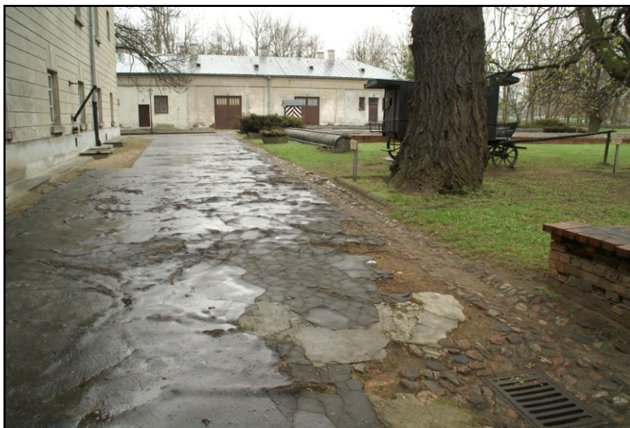
Fot. nr 15 Nawierzchnia asfaltowa, spękany asfalt, nieprawidłowe spadki, ubytki po remontach. Ciek wodny z kamienia polnego.
