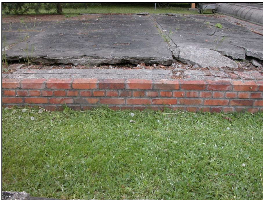
Fot. nr 30 Murek obrazujący przebieg starych fundamentów wartowni X Pawilonu, beton w złym stanie technicznym.
