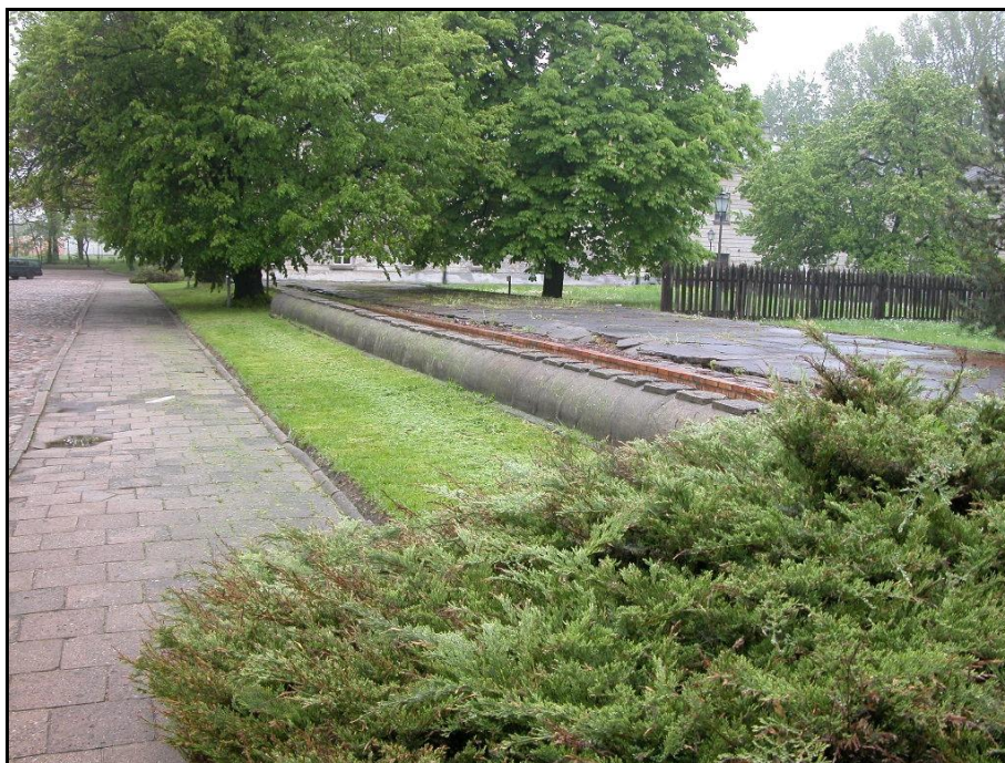
Fot. nr 7 Nawierzchnia chodnika z płyt betonowych o wym. 35 x 35 cm, zapadliska tworzące zastoiska wody opadowej. Kanał c.o. przykryty betonowymi łupinami.
