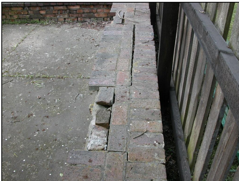
Fot. nr 38 Murek obrazujący przebieg starych fundamentów kuźni, nakrywa murku oraz beton w złym stanie technicznym.
