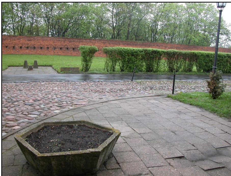
Fot. nr 5 Nawierzchnia chodnika z płyt betonowych o wym. 35 x 35 cm, zapadnięte płyty. Donica betonowa.
