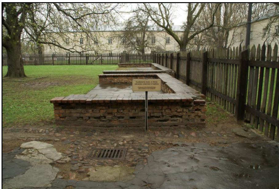
Fot. nr 34 Murek obrazujący przebieg starych fundamentów kuźni, murek oraz beton w złym stanie technicznym
