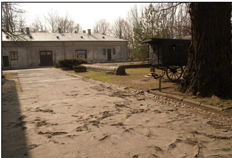
Fot. nr 17 Nawierzchnia asfaltowa. Odcinek silnie uszkodzony przez korzenie drzewa.
