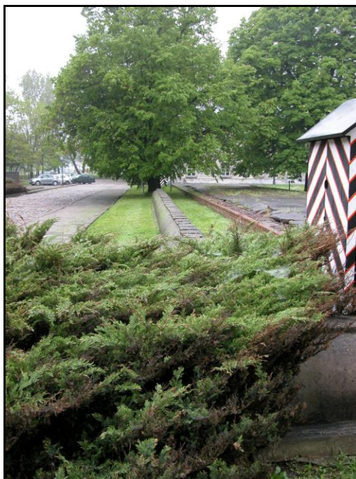
Fot. nr 22 Nawierzchnia trawiasta. Kanał c.o. przykryty łupinami z betonu.
