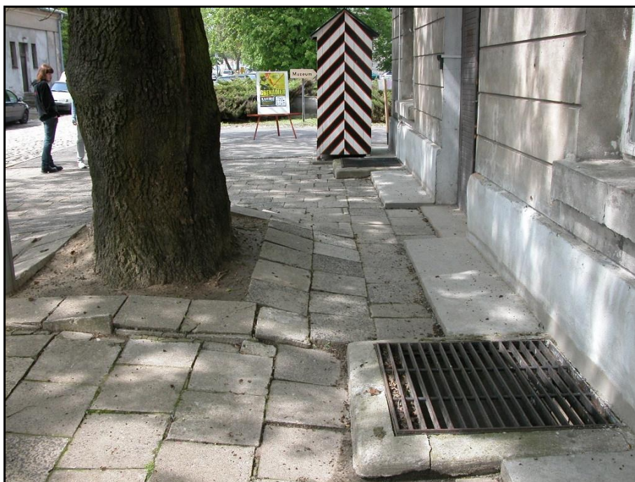
Fot. nr 10 Nawierzchnia chodnika z płyt betonowych o wym. 35 x 35 cm, wysadzone i spękane płyty wokół drzewa..
