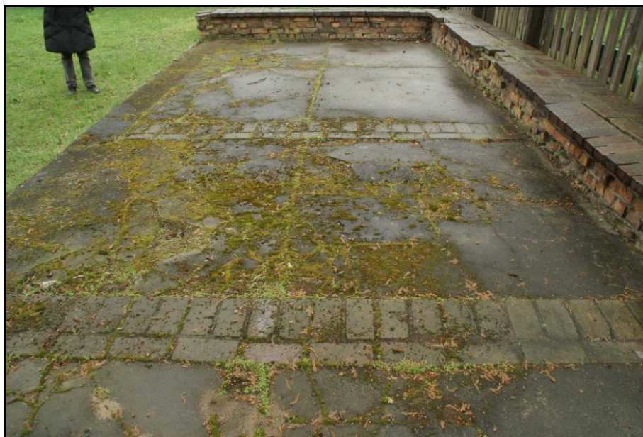
Fot. nr 36 Murek obrazujący przebieg starych fundamentów kuźni, murek oraz beton w złym stanie technicznym.
