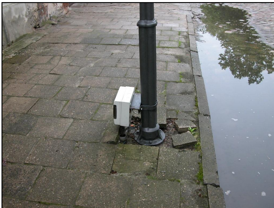
Fot. nr 6 Nawierzchnia chodnika z płyt betonowych o wym. 35 x 35 cm, spękanne płyty.
