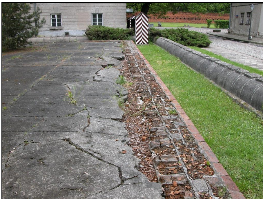
Fot. nr 33 Murek obrazujący przebieg starych fundamentów wartowni X Pawilonu, fragment murku w złym stanie technicznym.
