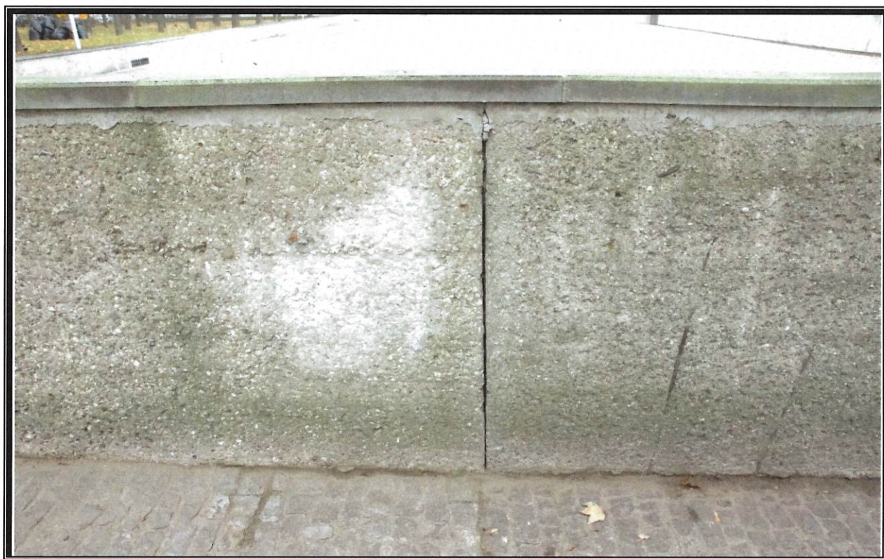
Fot. nr 6 i 7. Muzeum Więzienia Pawiak. Uszkodzony narożnik w górnej części u zbiegu ściany zachodniej i północnej Muzeum (powyżej). Zawansowany proces erozji na zach. płaszczyźnie zachodniego muru dziedzińca muzealnego z widocznymi ubytkami w licu ściany, skorodowanymi prętami zbrojenia i niewłaściwie opracowaną powierzchnią zaprawy mocującej płyty nakrywy. (poniżej). Stan zachowania z listopada 2019 r. Fot. W. Procyk..
