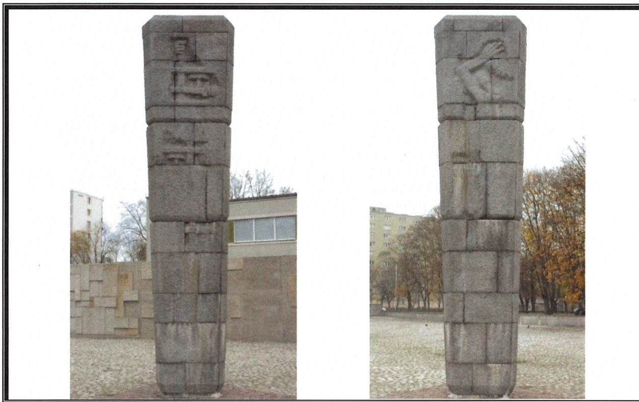
Fot. nr 17 - 20. Muzeum Więzienia Pawiak. Zmiany erozyjne na zewnętrznych płaszczyznach bloków i płasko-rzeźbionych motywów granitowego obelisku autorstwa Zofii Pociłowskiej, od strony Pn.-Zach (powyżej z lewej) i od str. Pd.-wsch. (powyżej z prawej). Zwarty osad substytutów zapraw cementowych i nacieki wytworzone w miejscach wyptywania składników zerodowanych spoiw z rdzenia obelisku (poniżej). Stan z listopada 2019 r. Fot. W. Procyk
