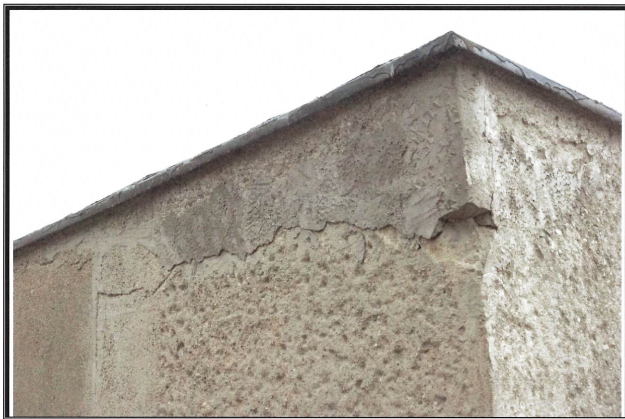
Fot. nr 6 i 7. Muzeum Więzienia Pawiak. Uszkodzony narożnik w górnej części u zbiegu ściany zachodniej i północnej Muzeum (powyżej). Zawansowany proces erozji na zach. płaszczyźnie zachodniego muru dziedzińca muzealnego z widocznymi ubytkami w licu ściany, skorodowanymi prętami zbrojenia i niewłaściwie opracowaną powierzchnią zaprawy mocującej płyty nakrywy. (poniżej). Stan zachowania z listopada 2019 r. Fot. W. Procyk..
