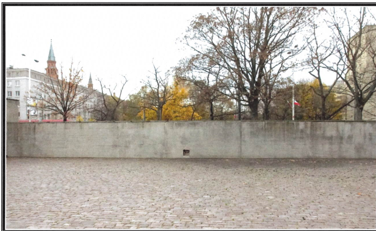
Fot. nr 10 - 11 i 12. Muzeum Więzienia Pawiak. Przykłady licznych spękań, uszkodzeń i ubytków w licu zachodniego muru dziedzińca muzealnego, wytworzone na skutek naprężeń w pozbawionym dylatacji, południowym odcinku muru (powyżej). Ogólny obraz zmian erozyjnych w południowej części wschodniej ściany, zachodniego muru dziedzińca z widoczną, pojedynczą szczeliną dylatacyjną (poniżej). Stan zachowania z listopada 2019 r. Fot. W. Procyk..
