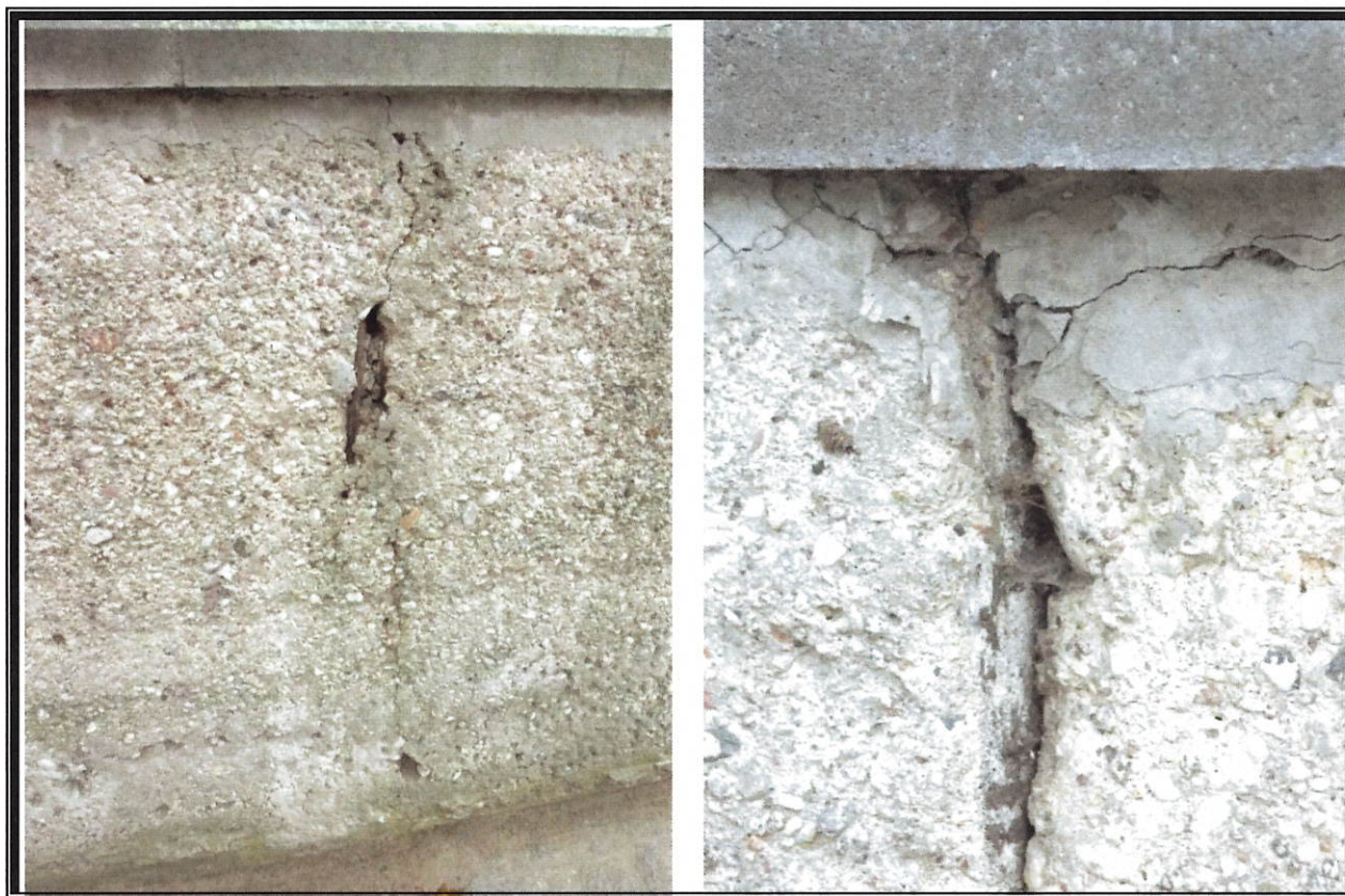
Fot. nr 10 - 11 i 12. Muzeum Więzienia Pawiak. Przykłady licznych spękań, uszkodzeń i ubytków w licu zachodniego muru dziedzińca muzealnego, wytworzone na skutek naprężeń w pozbawionym dylatacji, południowym odcinku muru (powyżej). Ogólny obraz zmian erozyjnych w południowej części wschodniej ściany, zachodniego muru dziedzińca z widoczną, pojedynczą szczeliną dylatacyjną (poniżej). Stan zachowania z listopada 2019 r. Fot. W. Procyk..
