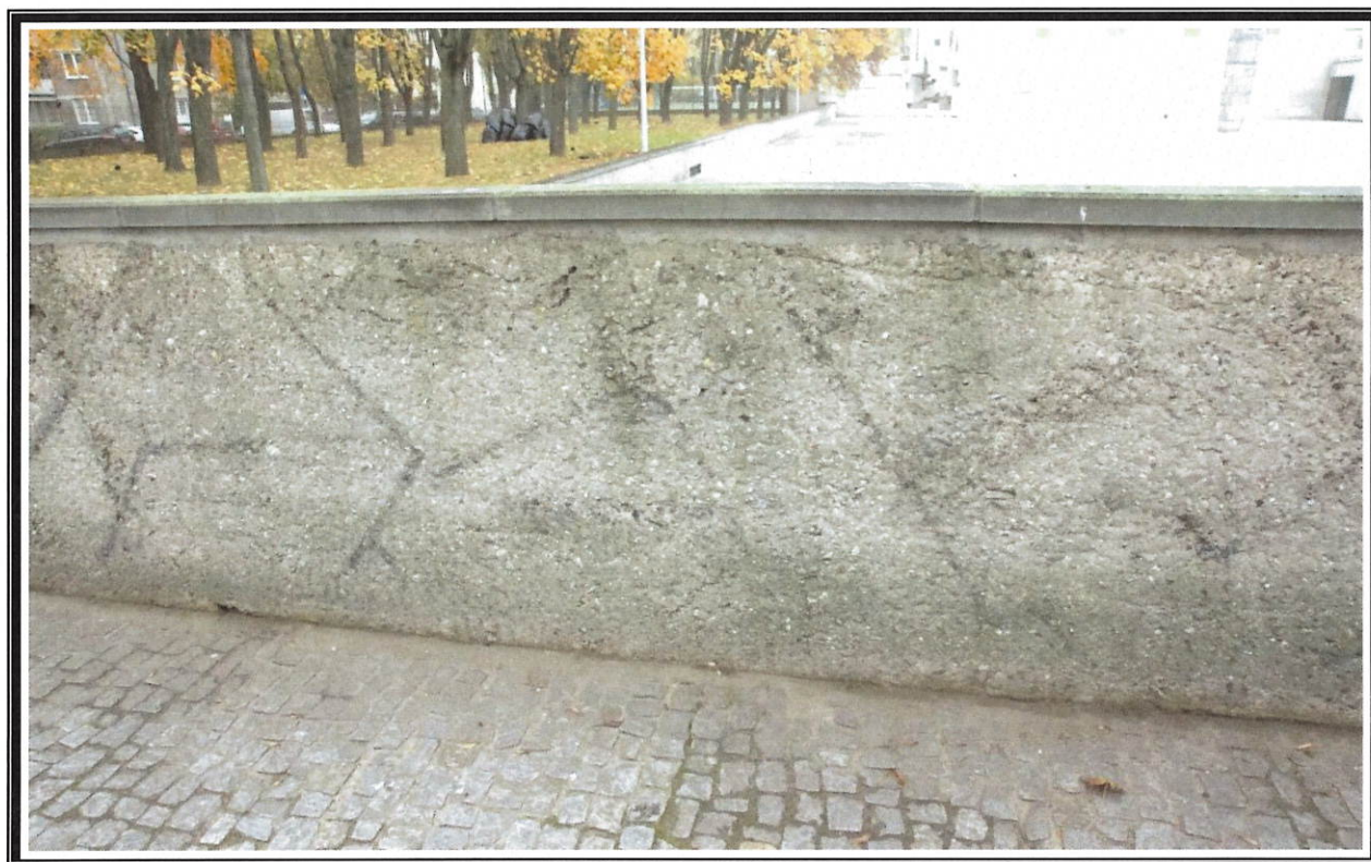
Fot. nr 8 i 9. Muzeum Więzienia Pawiak. Uszkodzona pionowym pęknięciem struktura w południowej części zachodniego muru dziedzińca muzealnego, wytworzonym przez napór systemu korzeniowego sąsiadującego drzewa (powyżej). Liczne, kolorystyczne pozostałości graffiti na płaszczyźnie północnego odcinka zachodniego muru dziedzińca (poniżej). Stan zachowania z listopada 2019 r. Fot. W. Procyk..
