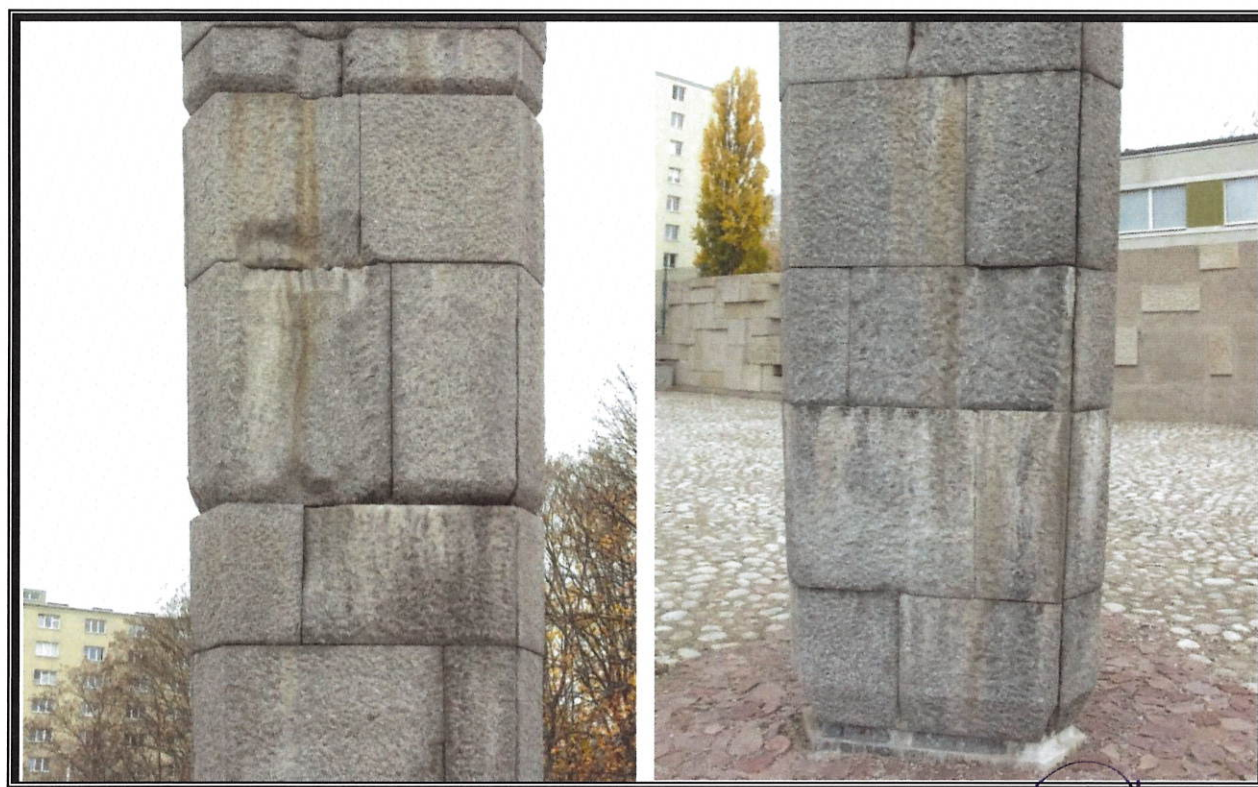
Fot. nr 17 - 20. Muzeum Więzienia Pawiak. Zmiany erozyjne na zewnętrznych płaszczyznach bloków i płasko-rzeźbionych motywów granitowego obelisku autorstwa Zofii Pociłowskiej, od strony Pn.-Zach (powyżej z lewej) i od str. Pd.-wsch. (powyżej z prawej). Zwarty osad substytutów zapraw cementowych i nacieki wytworzone w miejscach wyptywania składników zerodowanych spoiw z rdzenia obelisku (poniżej). Stan z listopada 2019 r. Fot. W. Procyk
