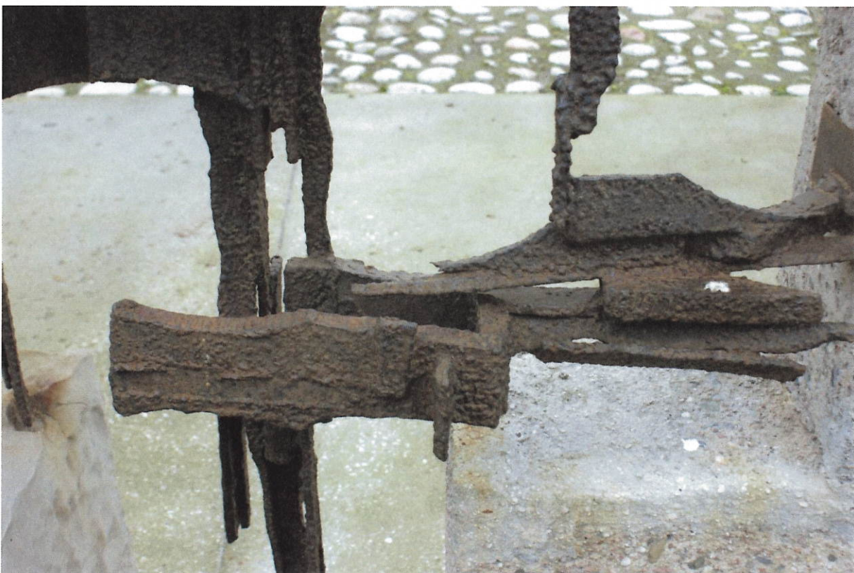
fot. 8 - 11. Krata III z muru pawiaczkiego, widok od strony ulicy; widok fragmentów kraty od strony ulicy. Listopad 2019 r.
