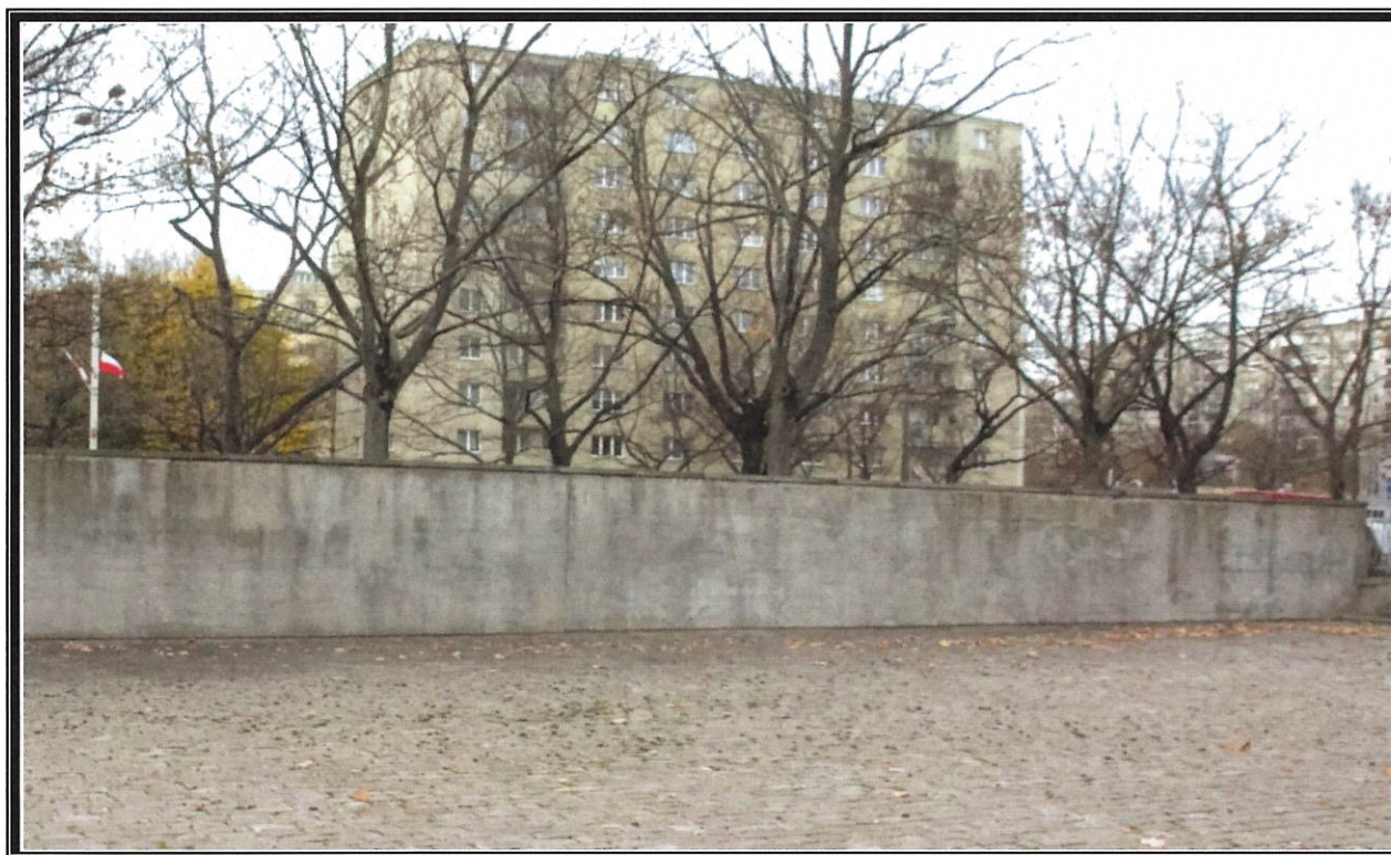
Fot. nr 13 i 14. Muzeum Więzienia Pawiak. Ogólny obraz zmian erozyjnych w północnej części wschodniej ściany, zachodniego muru dziedzińca (powyżej). Liczne ślady usuwania graffiti i przemalowań na licu wschodniego odcinka północnej ściany Muzeum, od strony dziedzińca (poniżej). Stan z listopada 2019 r. Fot. W. Procyk
