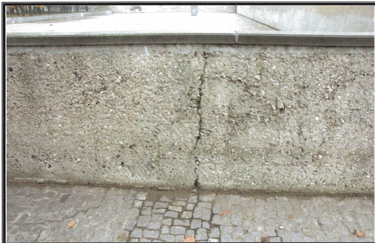
Fot. nr 8 i 9. Muzeum Więzienia Pawiak. Uszkodzona pionowym pęknięciem struktura w południowej części zachodniego muru dziedzińca muzealnego, wytworzonym przez napór systemu korzeniowego sąsiadującego drzewa (powyżej). Liczne, kolorystyczne pozostałości graffiti na płaszczyźnie północnego odcinka zachodniego muru dziedzińca (poniżej). Stan zachowania z listopada 2019 r. Fot. W. Procyk..
