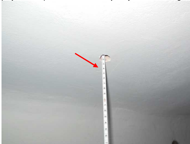
Fot. 6. Widok na miejsce wykonanego pomiaru grubości płyty stropowej nad parterem (32cm) w magazynku przybudówki po stronie wschodniej skrzydła wschodniego.
