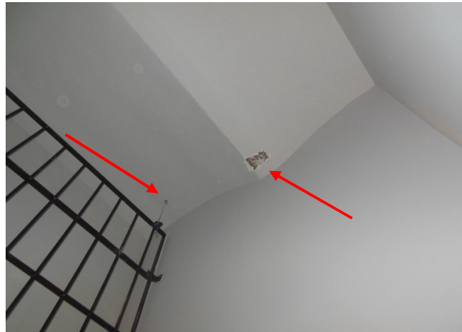
Fot. 18. Widok na miejsca wykonanego otworu przewiertu przez płytę stropu oraz pomierzoną szerokość belki stalowej stropu Kleina (92mm) zlokalizowanego nad parterem w części pomieszczeń za klatką schodową zlokalizowaną w środkowej części skrzydła zachodniego bud. X Pawilonu.
