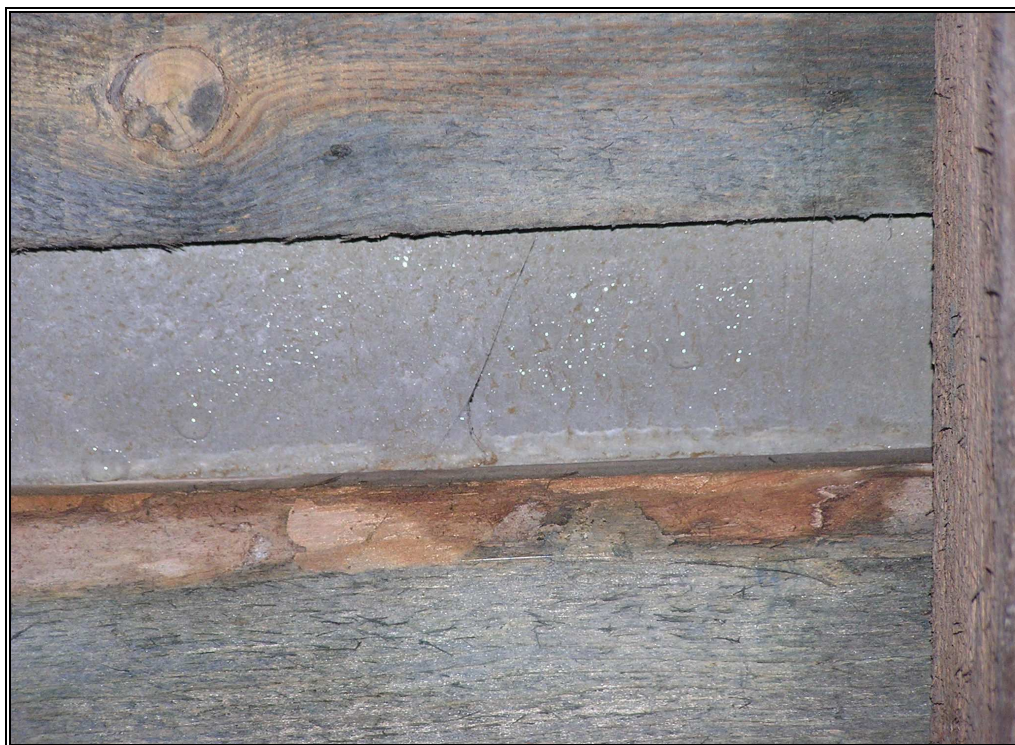
19. Skrzydło wschodnie. Krople wody na spodzie pokrycia dachu z blachy w rejonie krokwi, część wschodnia skrzydła.
