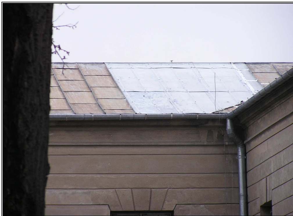
6. Narożnik północno – wschodni. Fragment reperacji na dachu.
