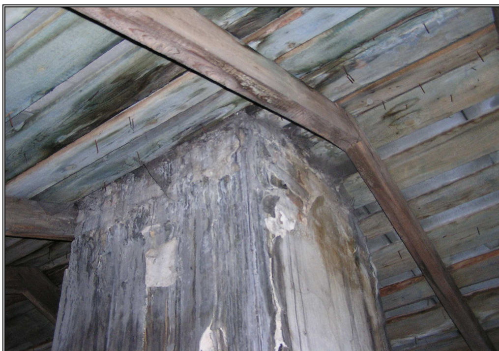
16. Skrzydło wschodnie. Zawilgocenia deskowania w rejonie krokwi wraz z zaciekiem i uszkodzeniami tynku na kominie, część środkowa skrzydła.
