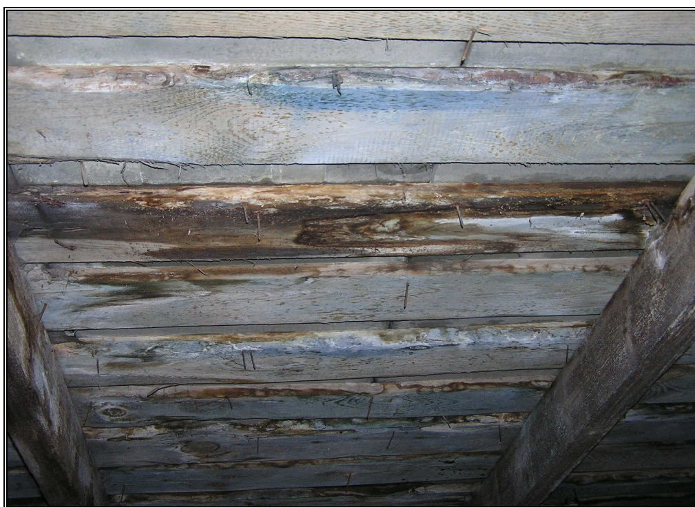
12. Skrzydło wschodnie. Zawilgocenia deskowania pomiędzy krokwiami, część wschodnia skrzydła.
