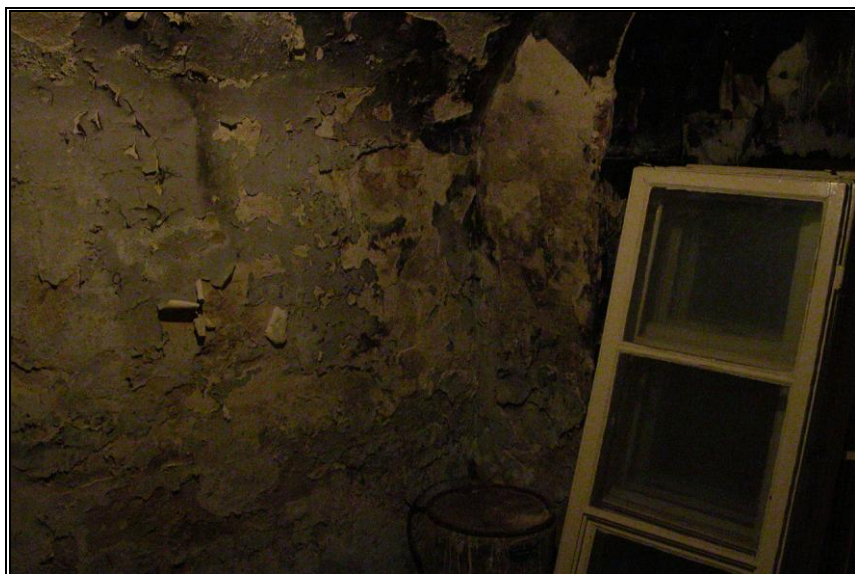
9. Skrzydło wschodnie. Piwnice, zawilgocenia i korozja tynku.
