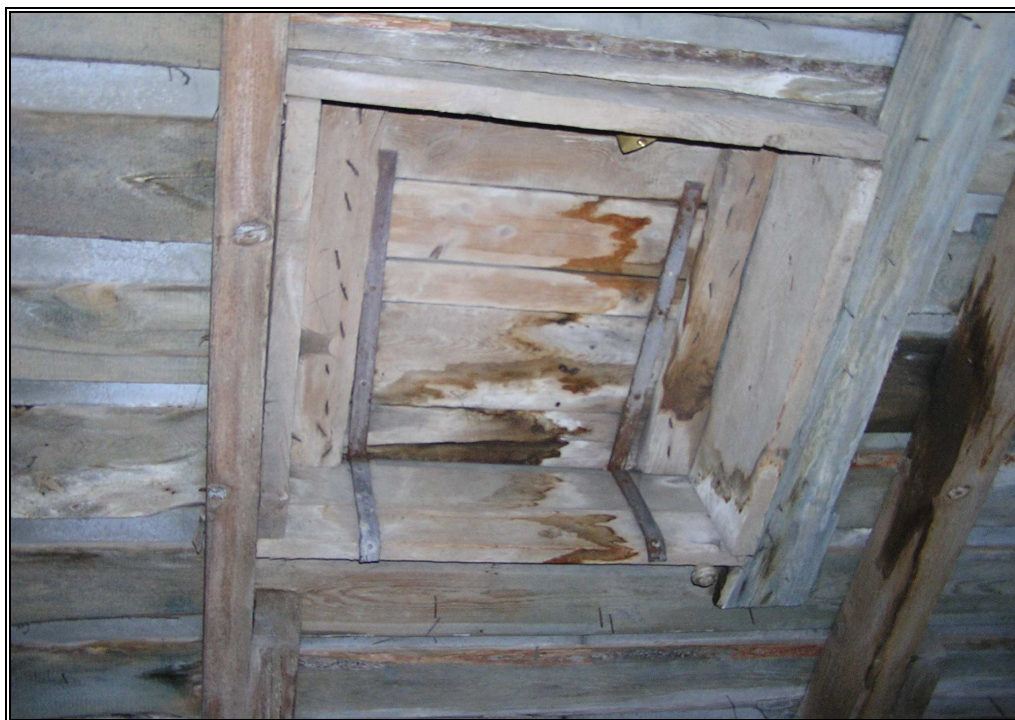
14. Skrzydło wschodnie. Zawilgocenia wyłazu na dach oraz krokwi, część środkowa skrzydła.
