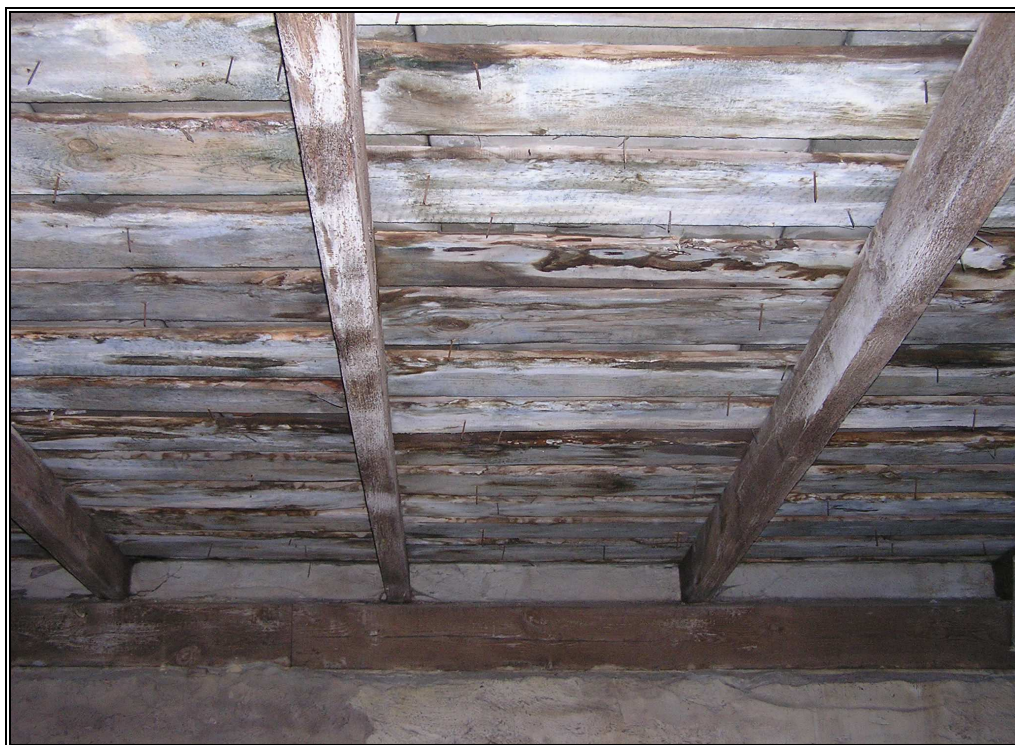
17. Skrzydło wschodnie. Zawilgocenia deskowania oraz wysolenia w rejonie, część wschodnia skrzydła.
