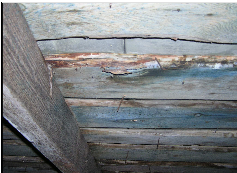
11. Skrzydło wschodnie. Zawilgocenia deskowania w rejonie krokwi, część południowa skrzydła.
