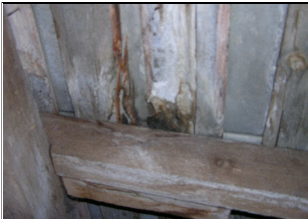
13. Skrzydło wschodnie. Zawilgocenia w rejonie krokwi, część wschodnia skrzydła.
