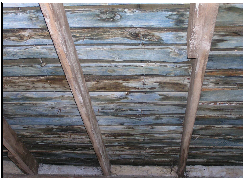
27. Skrzydło północne. Zawilgocenia i wysolenia w rejonie krokwi, część północna skrzydła.
