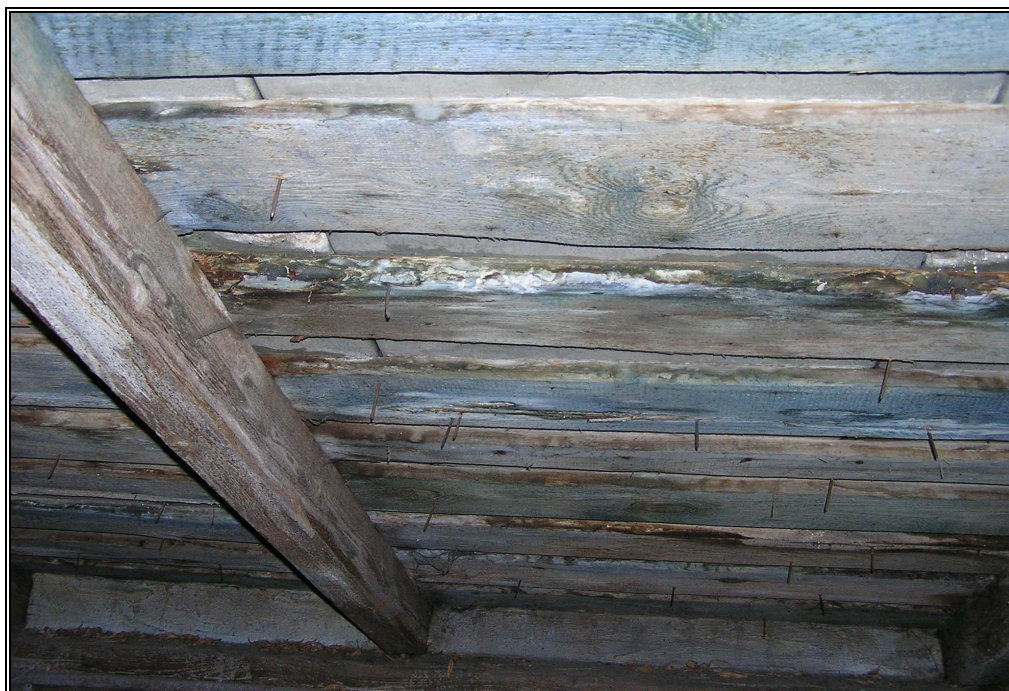
9. Skrzydło wschodnie. Zawilgocenia deskowania oraz wysolenia w rejonie krokwi, część południowa skrzydła.
