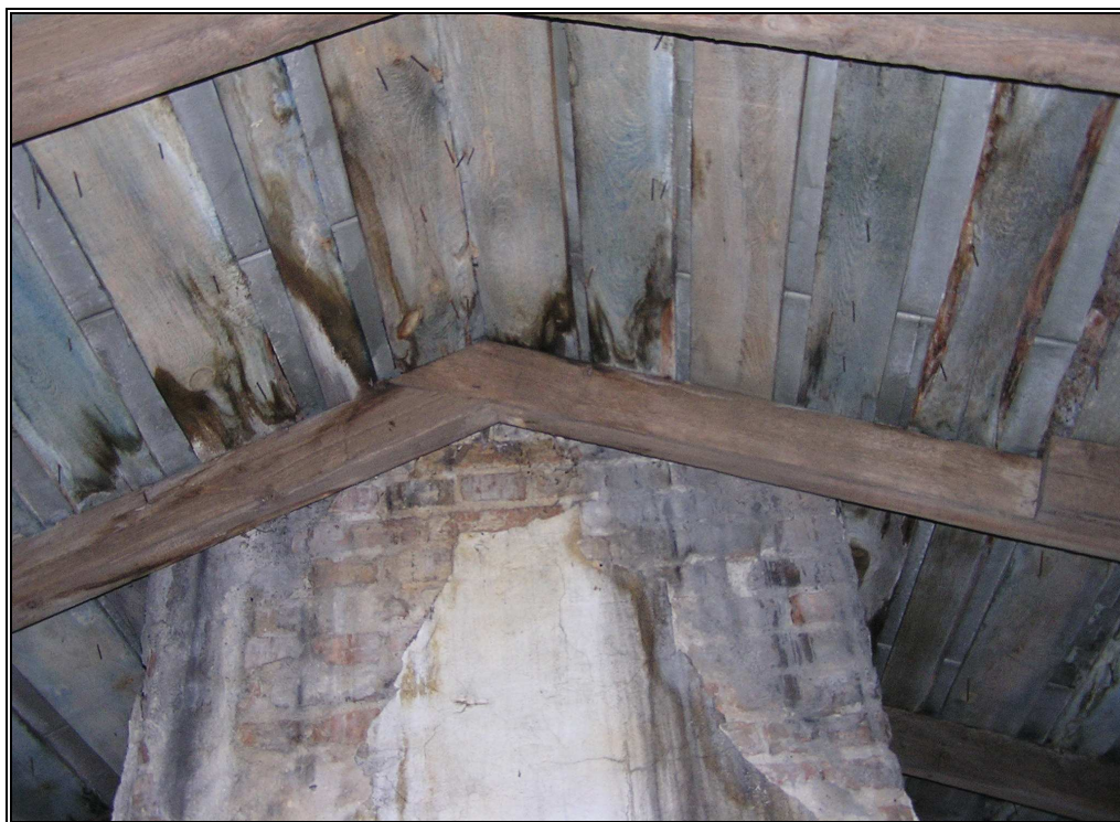
15. Skrzydło wschodnie. Zawilgocenia deskowania w rejonie krokwi wraz z uszkodzeniami tynku na kominie, część środkowa skrzydła.
