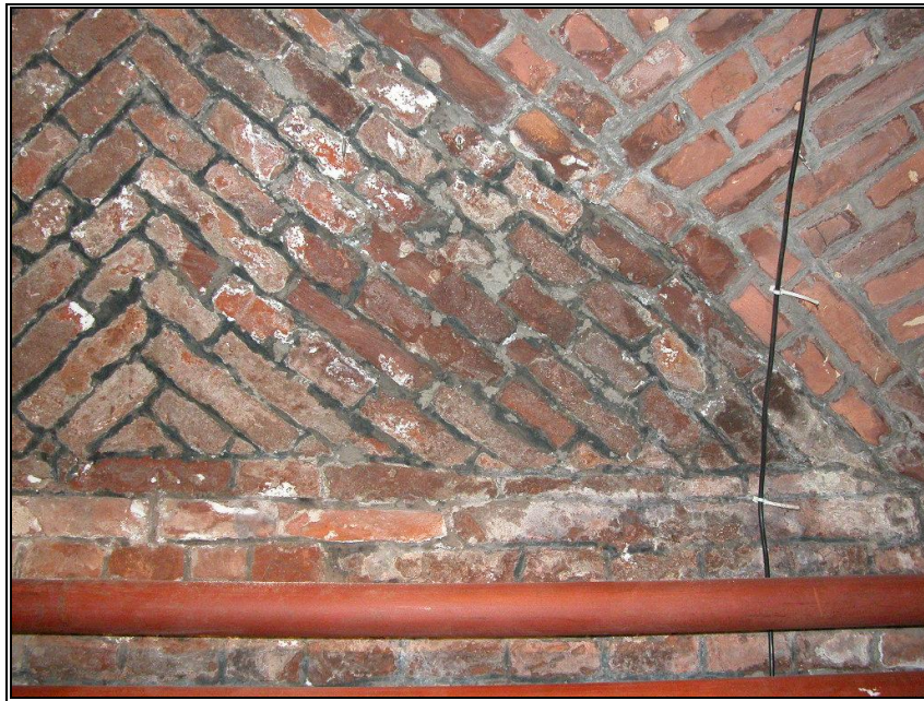
1. Skrzydło zachodnie. Piwnice, wysolenia na ścianach.
