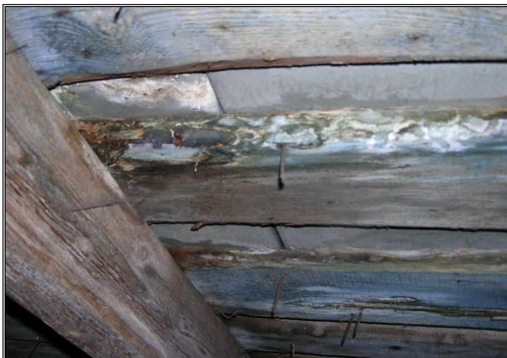
10. Skrzydło wschodnie. Szczegół zawilgocień deskowania oraz wysoleń w rejonie krokwi.
