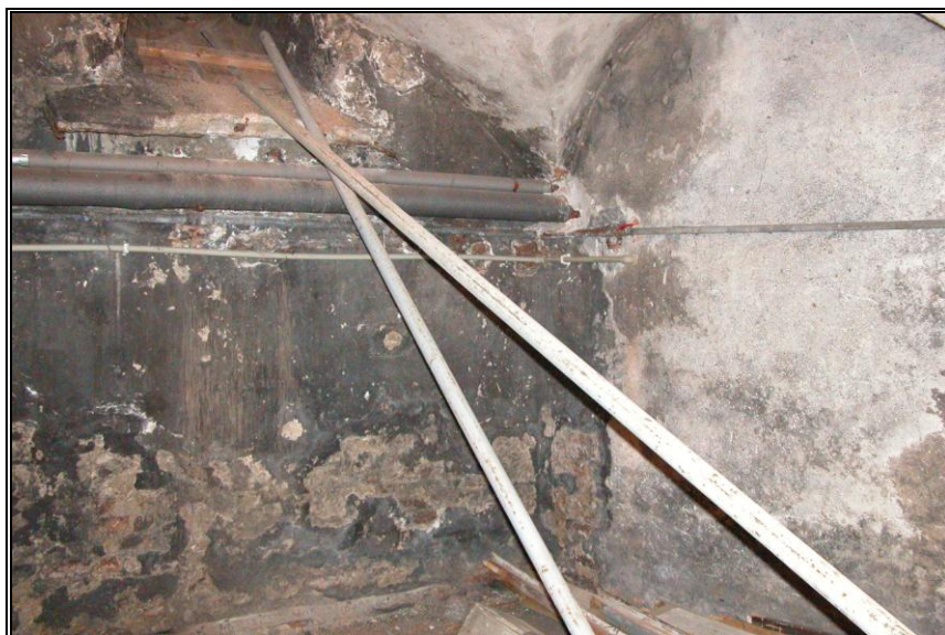
5. Skrzydło wschodnie. Piwnice, zawilgocenia i korozja tynku.
