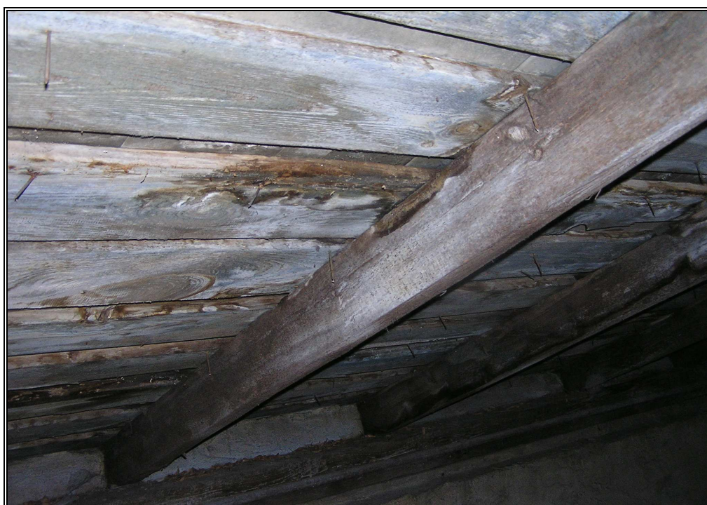
8. Skrzydło wschodnie. Zawilgocenia krokwi wraz z deskowaniem, część południowa skrzydła.
