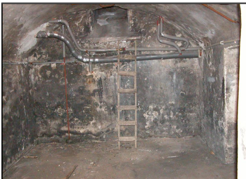
6. Skrzydło wschodnie. Piwnice, zawilgocenia i korozja tynku.
