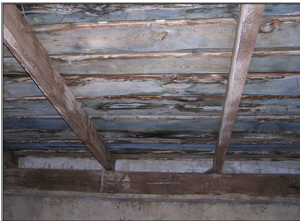
24. Skrzydło wschodnie. Zawilgocenia deskowania oraz wysolenia w rejonie krokwi, część wschodnia skrzydła.
