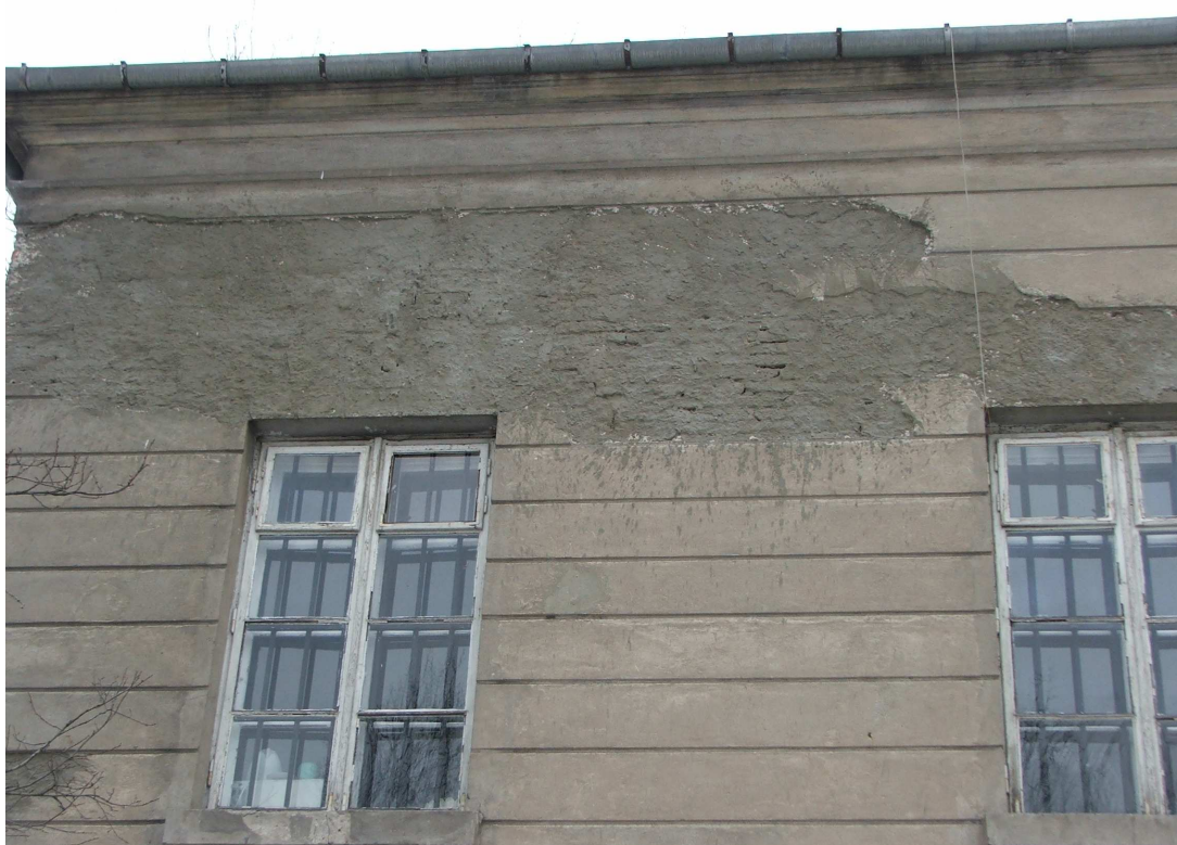
X Pawilon Cytadeli Warszawskiej, skrzydło zachodnie, elewacja południowa, zbliżenie, widoczny rozległy ubytek tynku zabezpieczony cementowym szprycem.
